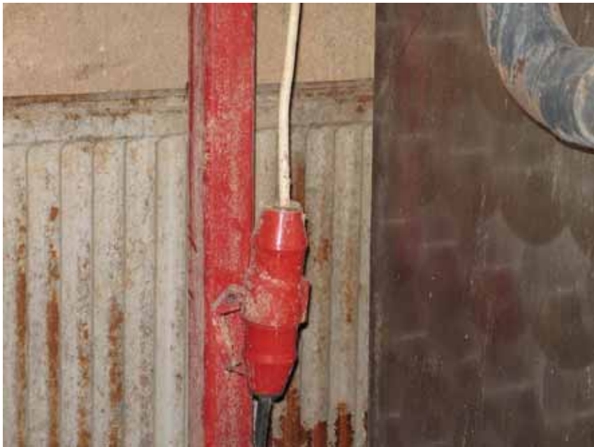
Kuva 11. Kiinteään asennukseen tarkoitettu MMJ-kaapeli jatkopistorasiassa.
