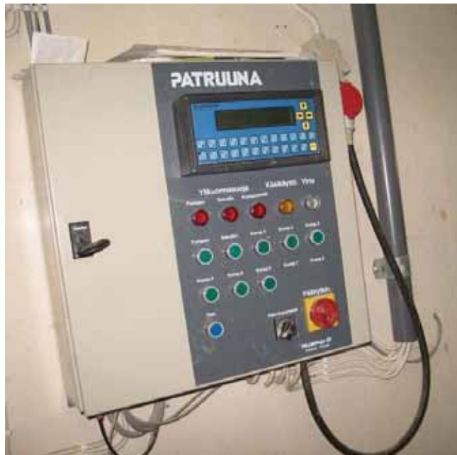
Kuva 8. Pistotulpalla sähköverkkoon liitetty kiinteä keskus.
